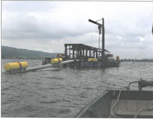
Gas bald auch für Hitzkirch: Auf dem Baldeggersee wird die Gasleitung verlegt.
