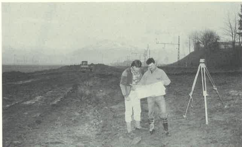
21. Februar 1994: In Waldibrücke wurde mit der Sanierung der Seetalbahn begonnen.
