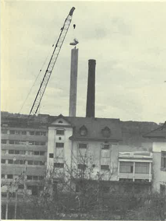
▲ Demontage des Südi-Kamins
